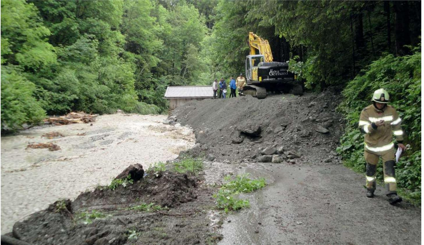
Die Wildbach- und Lawinerverbauung wird im Auftrag der örtlichen Schutzwassergenossenschaft am Brandenauerbach ab September 2021 Hochwasserschutzmaßnahmen am Talausgang des Brandenauerbaches herstellen. Geplant ist die Errichtung eines Filterbauwerks bei hm 4,02, um Schwemmholz und Geschiebe aus dem Wildbachprozess ausfiltern zu können. Gerade das Hochwasser vom 2. Juni 2013 hatte gezeigt, welche enormen Gefahrenpotentiale aus dem Griesergraben zu erwarten sind.
